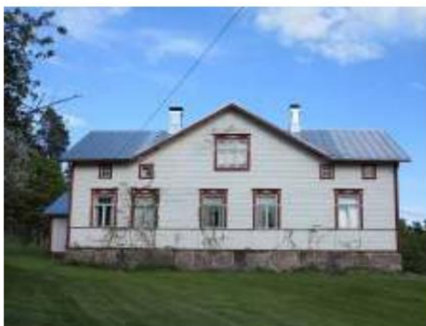
651 Jutansin päärakennus 1800-luvun lopulta.
