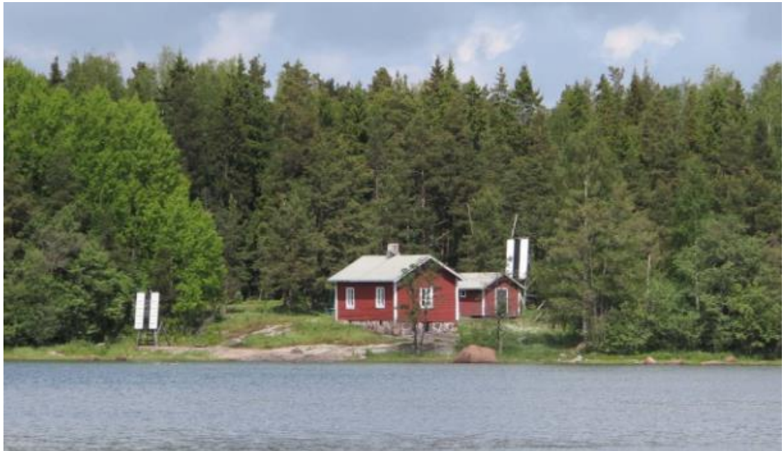
Kuva 3-5. Skansuddenin luotsiasema. Satulakattoinen, tyyppiirustusten mukaan rakennettu mökki käsittää eteisen, kamarin ja tuvan. Kokonaisuuteen kuuluvat varastorakennus, linjataulut ja rannan hirsiarkkulaituri. (Kuva: Inkoon sisäsaariston kulttuuriympäristöselvitys, s. 61 (Stadionark 2012).
