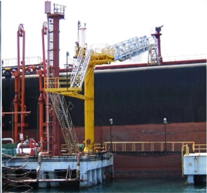
Kuva 5. Esimerkki pylvästyypisestä mairinnoususillasta (Verhoef)
