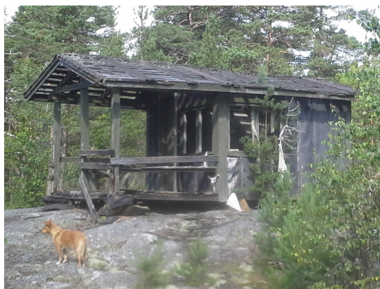
Kuva 8. Valokuva kaava-alueen eteläosassa olevasta vanhasta rakennuksesta, joka on haettu purettavaksi.
