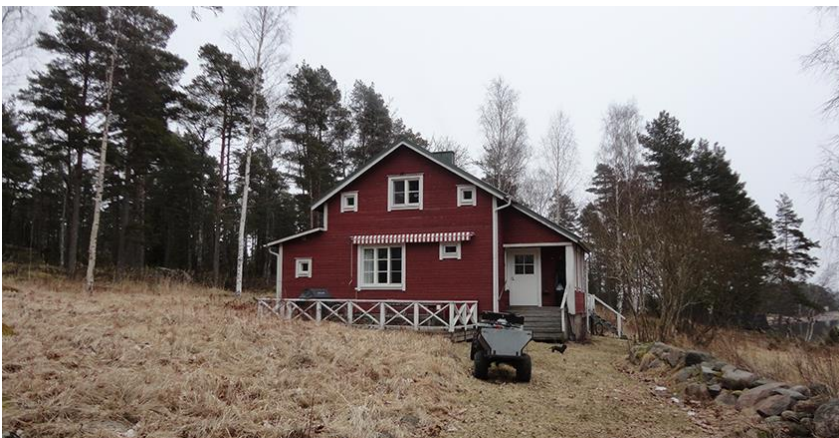
Kuva 1. Tilakeskuksen päärakennus (kartalla 1). Rakennusta on peruskorjattu eri aikoina ja se lienee alkuperin rakennettu 1940-luvulla.
