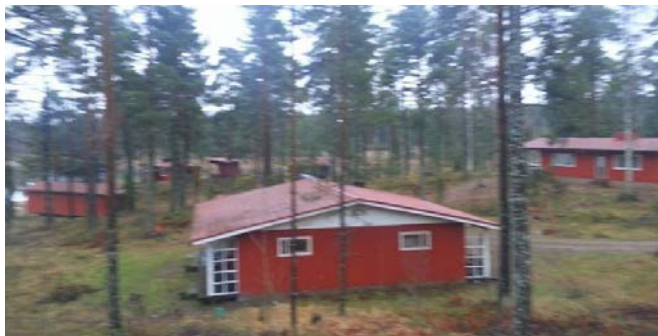
Övernattningsbyggnader, båthus och strandbastun. Majoitusrakennuksia, venevaja ja rantasaunoja.
