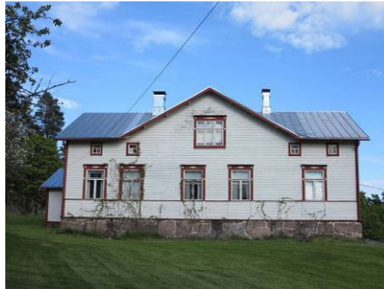
651 Jutansin huvudbyggnad från 1800-talets slut.
