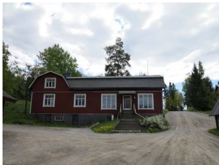
Andelslagets affärsbyggnad från 1921 (631)
