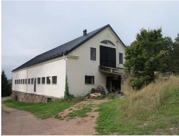
Kalkullas fähus är uppfört 1939 av cementtegel på en äldre stenfoot av bruten sten.
