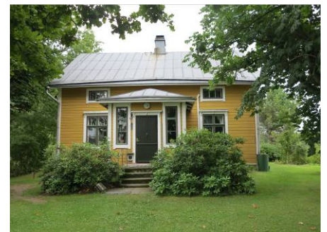
Sandsved on Lassaksen tilan entinen syytinkirakennus (954)
