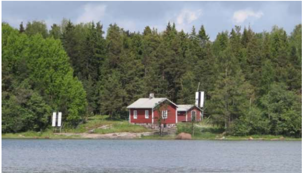
Bild 3-6. Skansuddens lotsstation. Stugan med sadeltak som byggts enligt typritningar omfattar en farstu, en kammare och enorstuga. I helheten ingår även en förrådsbyggnad, linjetavlor och en kistbrygga (foto: Kulturmiljöutredning för den inre skärgården i Ingå, s. 61. Stadionark 2012).
