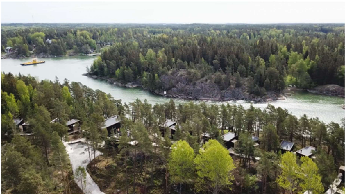
Kuva 3-2. Viistoilmakuva toteutuneesta rakentamisesta (kuvan lähde: https://www.thebaro.fi/tietoja-meista/ ).
