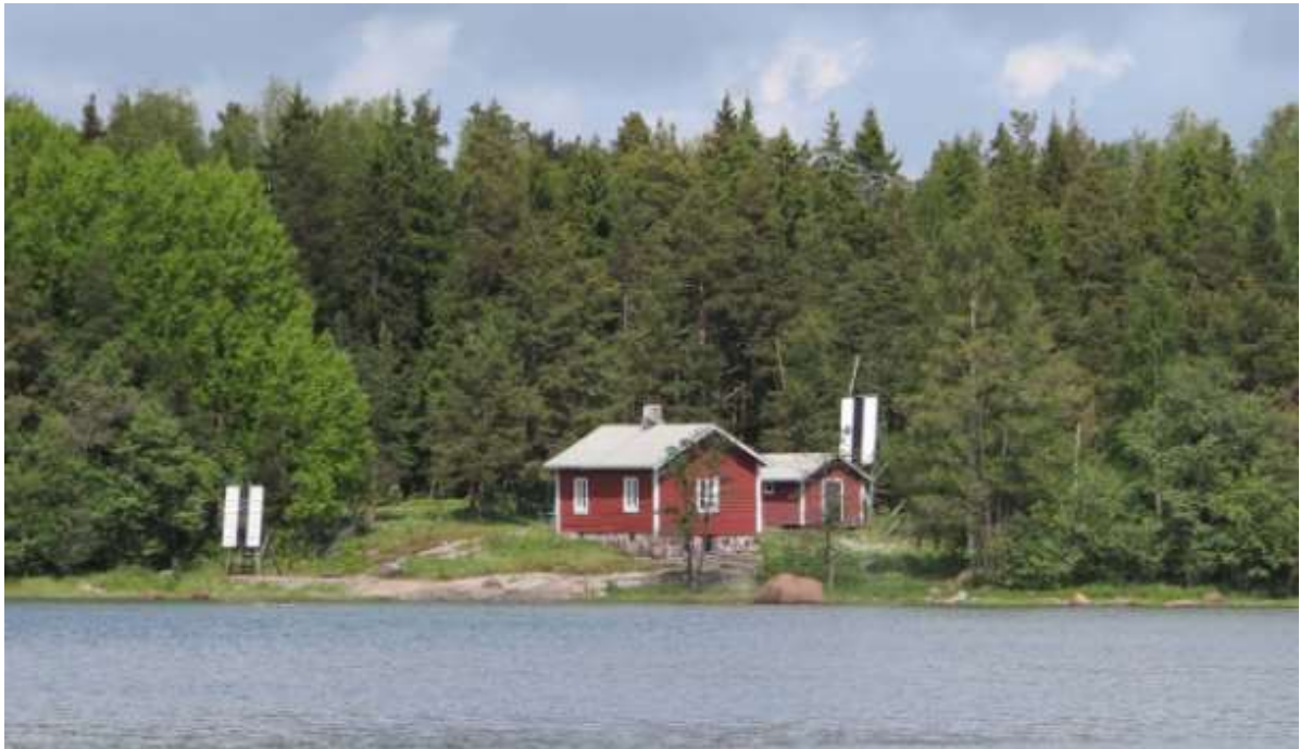
Kuva 3-6. Skansuddenin luotsiasema. Satulakattainen, tyyppipiirustusten mukaan rakennettu mökki käsittää eteisen, kamarin ja tuvan. Kokonaisuuteen kuuluvat varistorakennus, linjataulut ja rannan hirsiaikkulaituri (kuva: Inkoon sisäsaariston kulttuuriympäristöselvitys, s. 61. Stadionark 2012).
