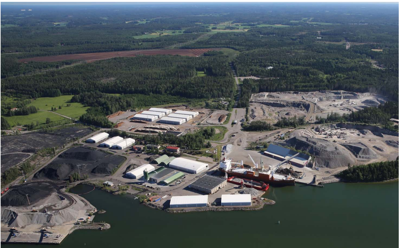
Figur 3-11. Övre bilden: Flygbild över Joddböleområdet mot väster, där områdets industripräglade landskap syns: i mitten lagringsfält för stenmaterial och i bakgrunden Inkoo Shippings hamnfunktioner med lyftkranar samt Fortums område med kolkraftverket i rivningsfas, med skorstenar och lagringshögar för kol. Nedre bilden: flygfoto från havet mot norr.
