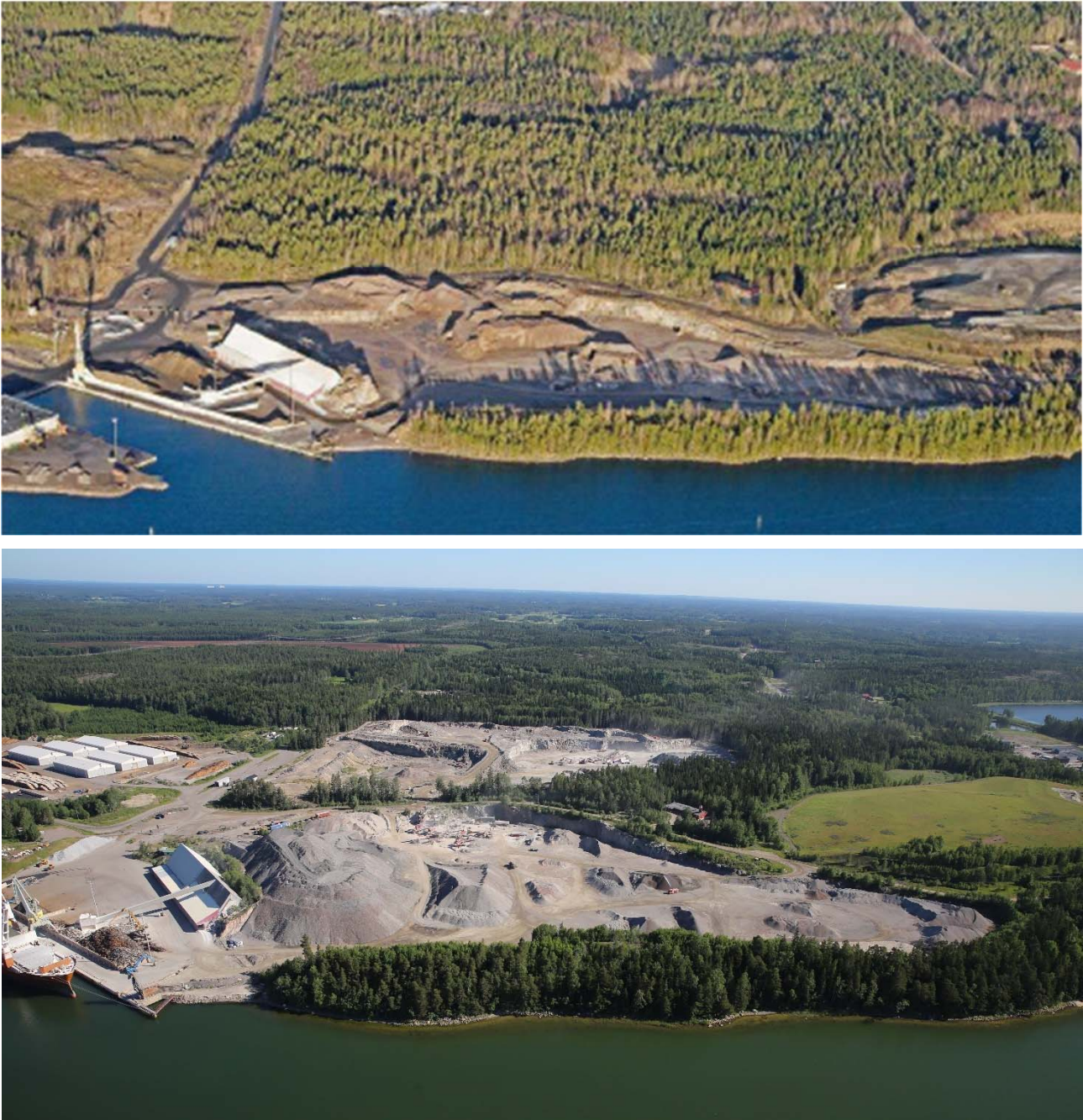
Figur 3-12. Landskapet fotograferat från luften, från havet mot norr. Den övre bilden är tagen 2009 i samband med detaljplaneringen av Joddböle (FCG Planeko Oy) och den nedre bilden 2019 på uppdrag av Inkoo Shipping Oy Ab. I bilden syns i förgrunden Rudus lagringsfält med sina höga stenmaterialhögar samt landskapsvallen parallell med stranden. I bakgrunden Vinbergets täktområde. I väster syns Ingå hamns funktioner och kajer.
