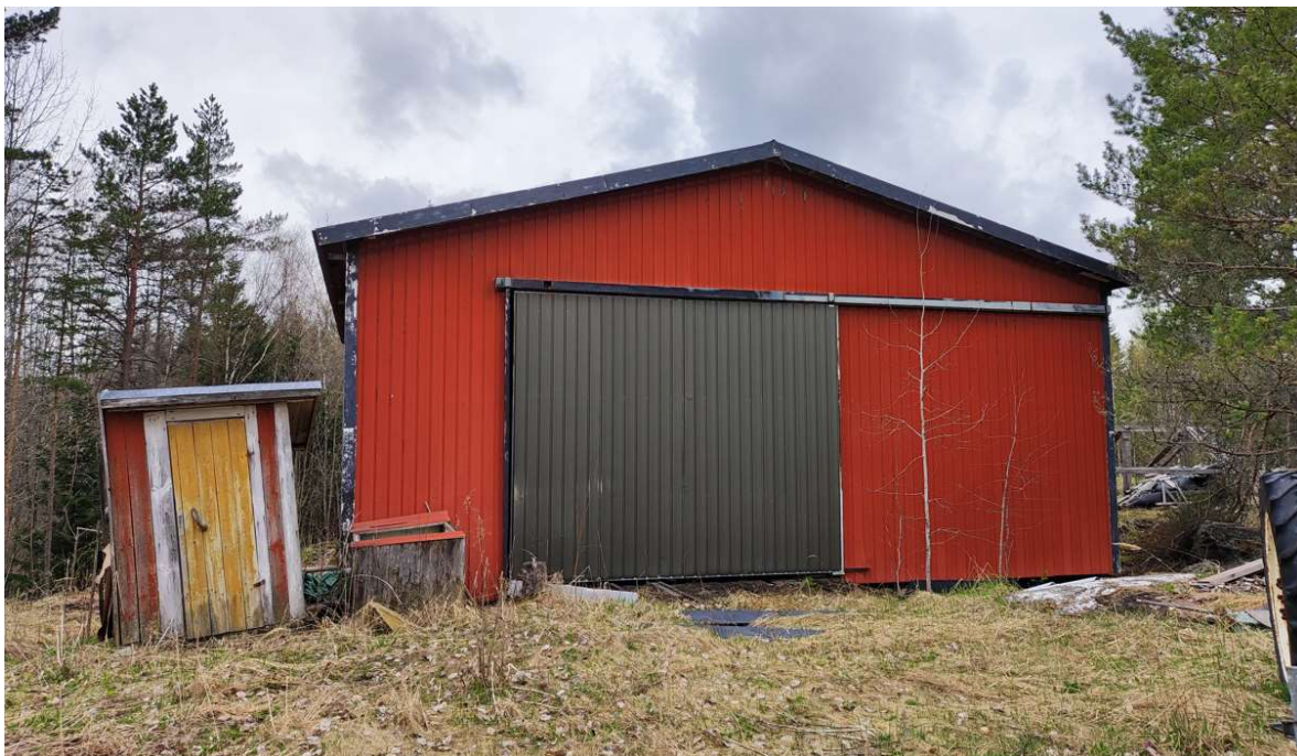
Bild 7: Ekonomibygnad på fastighet 149-412-2-20 (Ingå kommun, 2022).
