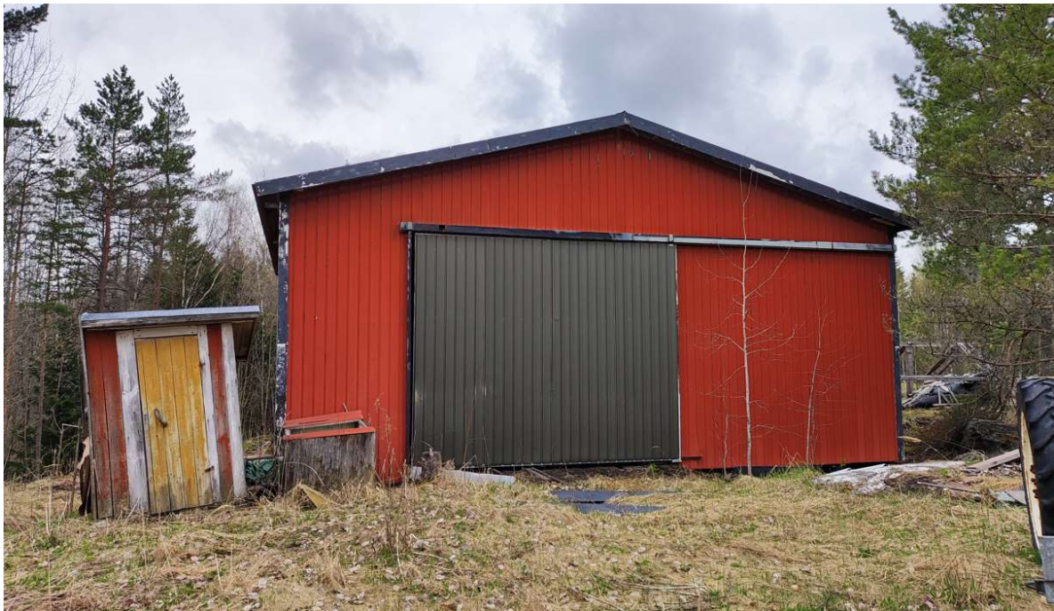
Kuva 7: Kiinteistöllä 149-412-2-20 sijaitseva talousrakennus (Inkoon kunta, 2022).
