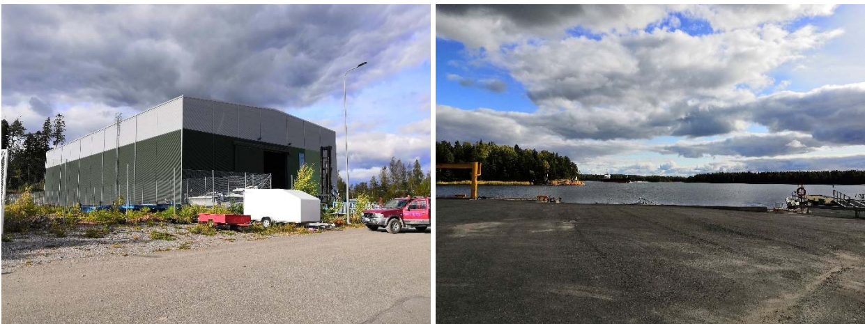
Kuva 3-5. Inkoon kalasatamassa sijaitseva veneiden talvisäilytyshalli sekä laiturit.
