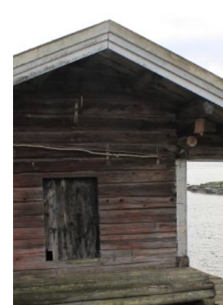
Hirsirakennus. Kuva Anni-Maija Fincke
