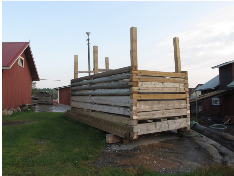
Bild 61. En timmerkista under konstruktion på Borstö i Pargas i september 2012. Foto Aki Leinonen.
