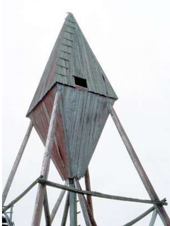
Kuva 64. Korsnäsän Svetgrundin sauvarakenteinen merimerkki on ainoa suurikokoinen jäljellä oleva sauvamerkki. Nyman 2009: 8.
