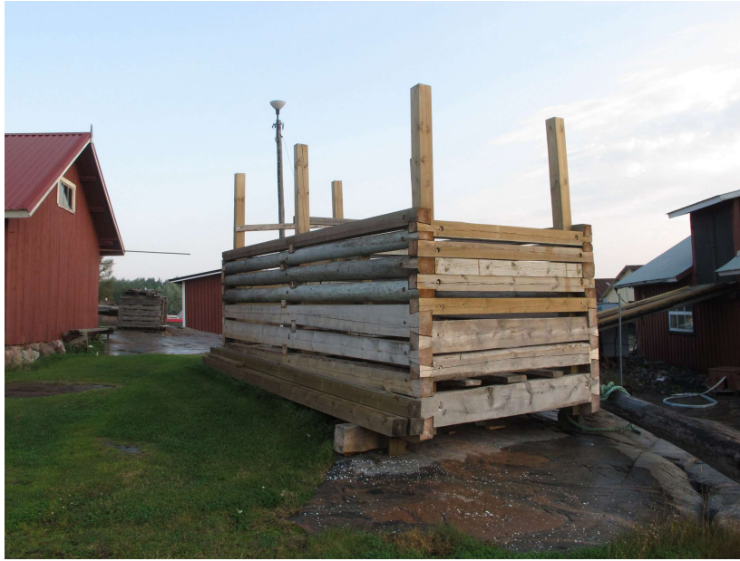
Kuva 61. Paraisten Borstöissä syyskuussa 2012 kuvattu rakenteilla oleva hirsiarkku. Kuva Aki Leinonen.
