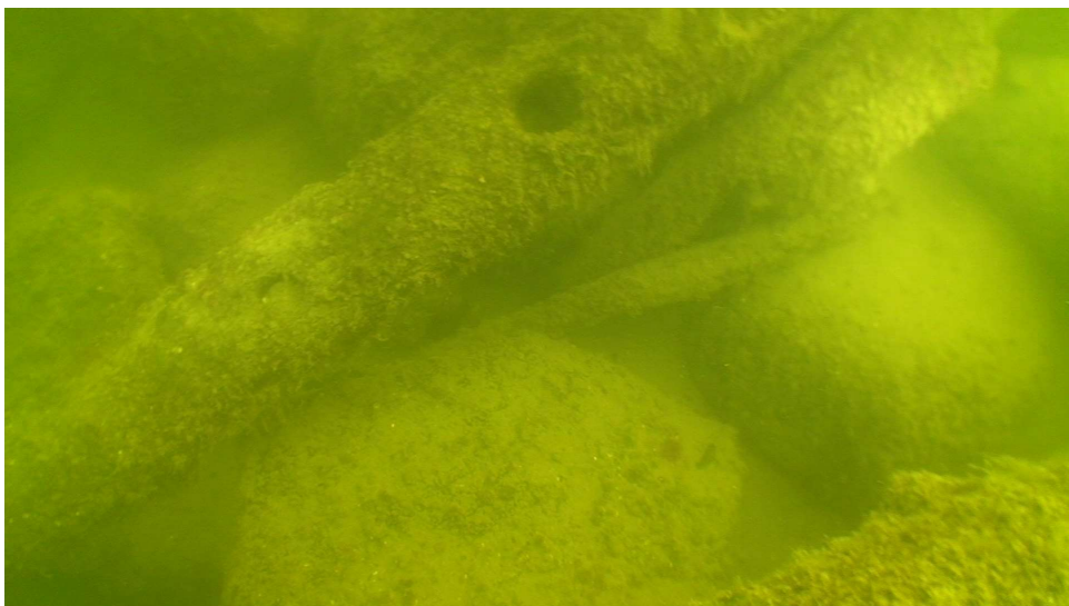
Kuva 60. Pyöreitä luonnonkiviä arkkurakennelman sisällä. Kuva Rami Kokko.
