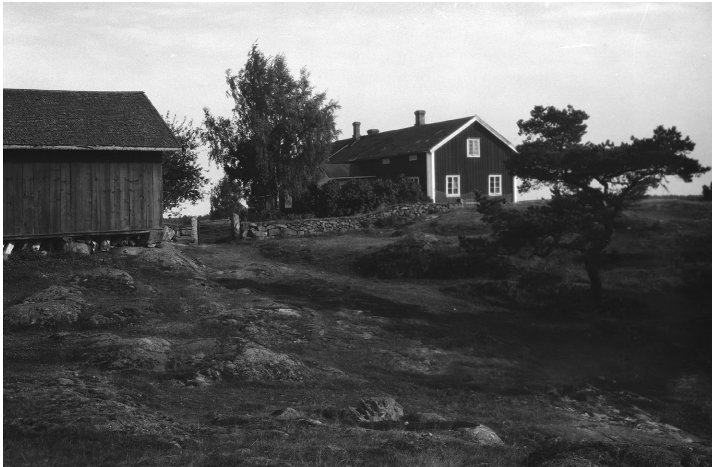
Bastön päärakennus Torsten Ranckenin kuvaamana 1931. Ihmisen tekemät rakenteet muotoilevat maastonmuotoja kuten kuvassa näkyvä kivimuuri. Rakennusten paikat on valittu tarkoin ja perustukset on aseteltu huolella maastoon. L-U mm 6.
