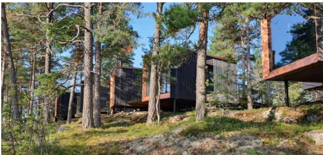
Bild 50: Bild av den redan byggda stugbyn. De små byggnaderna skymtar mellan träden. Stugorna urskiljs bäst i landskapet mot Barösunds farled under kvällen när ljuset från fönstren syns för passerande längs farleden. (Bild: The Barö)
