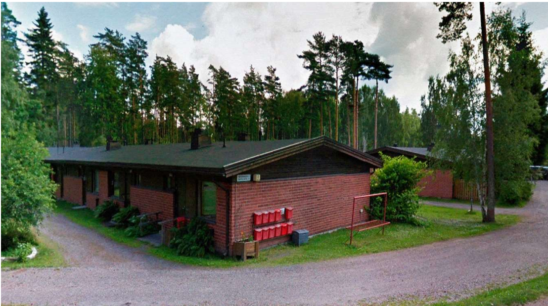
Kuva 13: Kiinteistöllä 149-412-2-101 sijaitsevaa rakennuskantaa.
