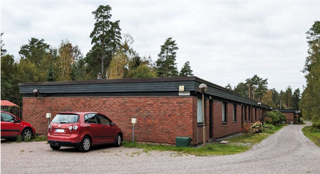
Kuva 12: Kiinteistöllä 149-412-2-100 sijaitsevaa rakennuskantaa.
