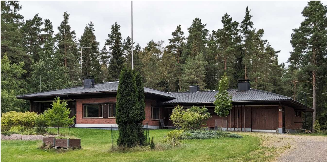
Kuva 6: Kiinteistöllä 149-412-1-12 sijaitseva asuinrakennus.
