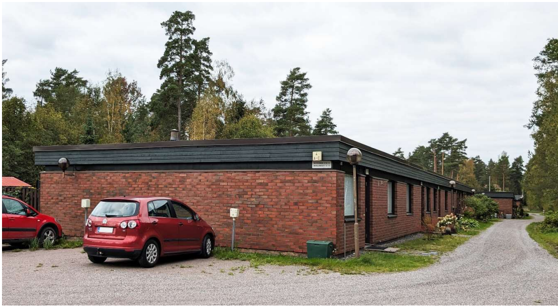
Bild 12: Byggnadsbestånd på fastigheten 149-412-2-100.
