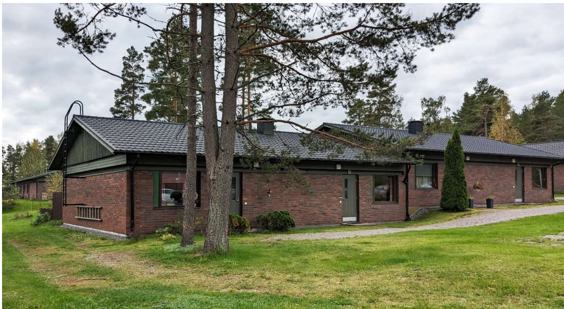
Bild 14: Radhusbyggnation i detaljplaneområdets omedelbara närhet. Byggnaderna ligger inte på detaljplaneområdet. Byggnaderna är terrasserade enligt terrängens höjdvariationer.
