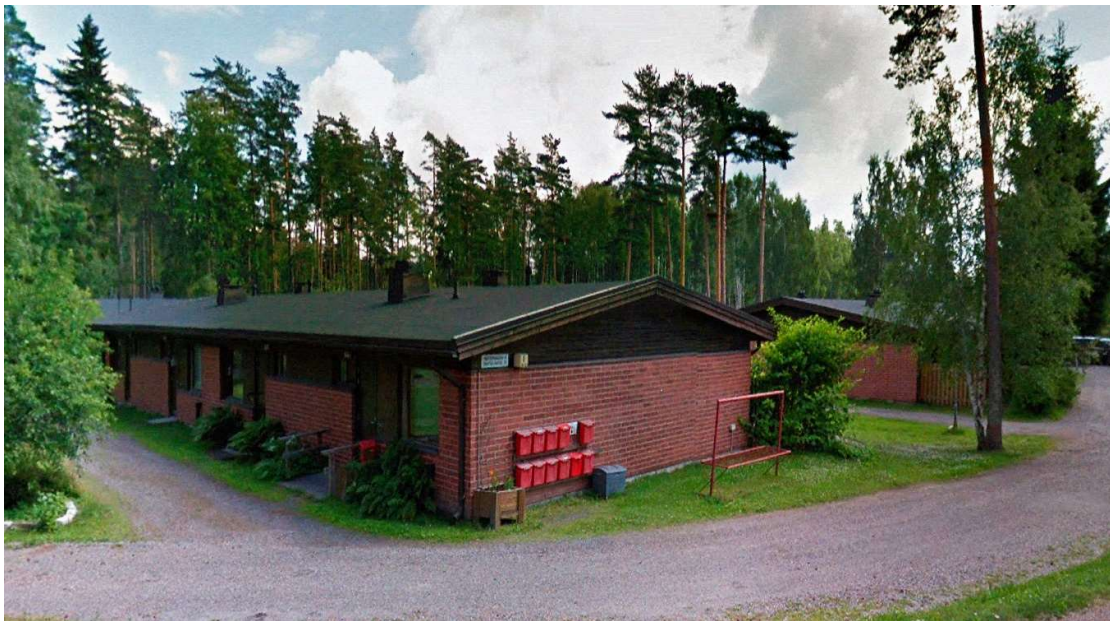
Bild 13: Byggnadsbestånd på fastigheten 149-412-2-101.
