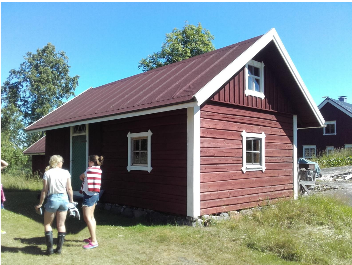
Bild 10. Vedlidret (10) med vedhuggararbetskraft i förgrunden. Byggnaden är i sin helhet förnyad.
