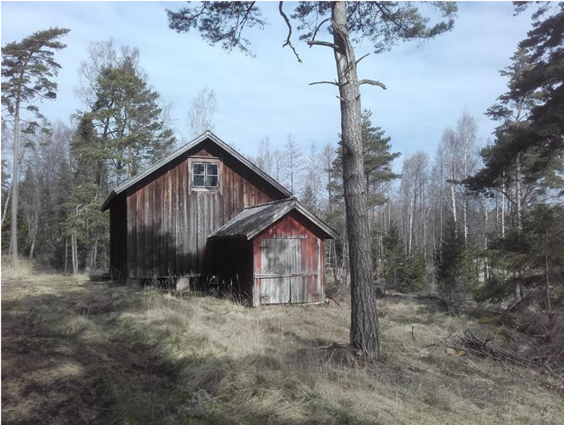
Kuva 9. Vanha puimala, Tröskhuset (8), on tarkoitus muuntaa asuinkäyttöön.
