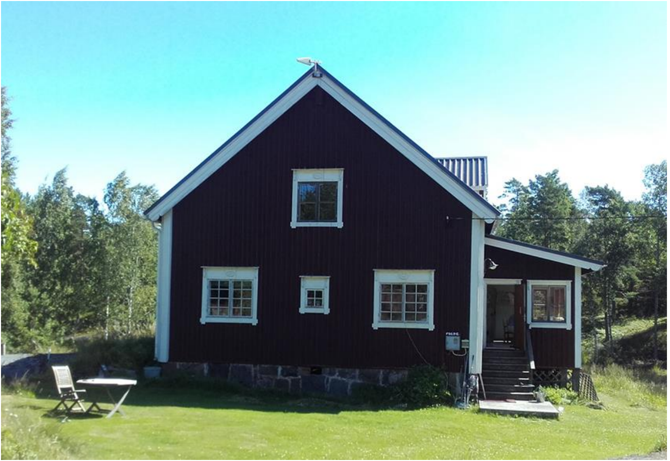
Kuva 2. Tilan toinen alkuperäinen asuinrakennus Fogde (2). Rakennus on kulttuurihistoriallisesti arvokas ja osoitetaan suojelumerkinnällä sr kaavakartasta ilmenevin kaavamääräyksin.
